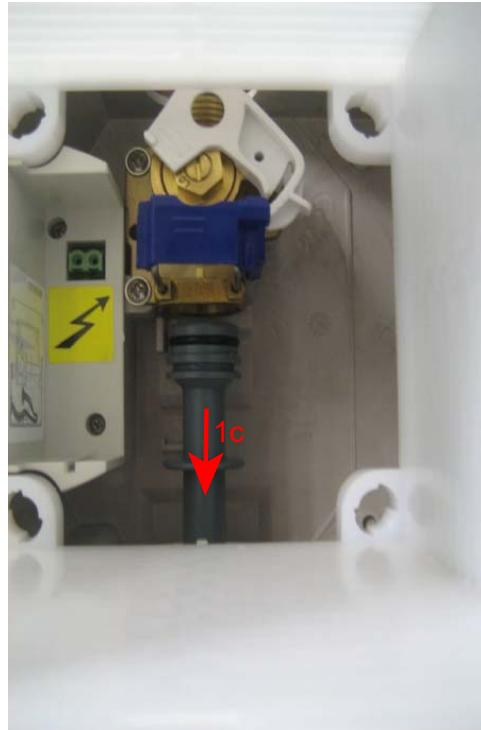
**2** 2a - poté zatlačit šedou propojku vpravo a vysunout z ventilu
